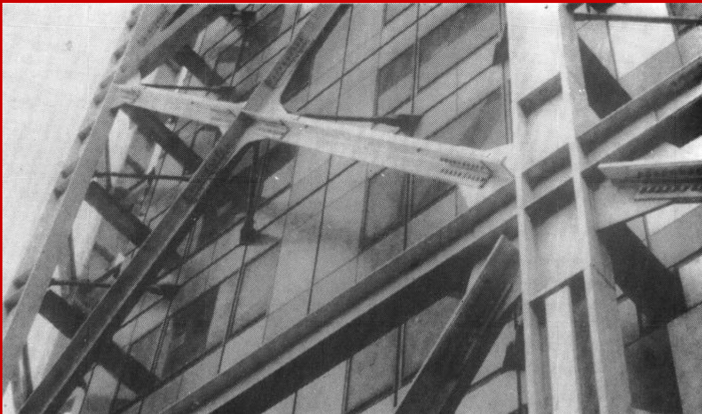
ЕКСТЕРНА НОСЕЧКА КОНСТРУКЦИЈА
