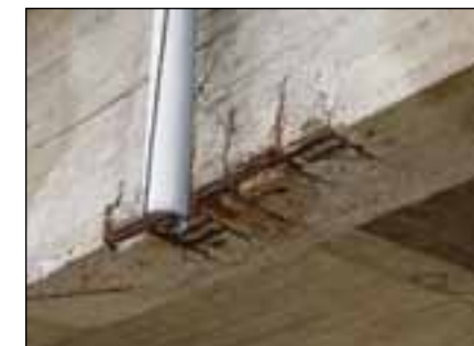
Сл. 3 Алармантни оштетувања на мостовските конструкции на автопатот Скопје – Велес кои пред сè се должат на несоодветното одржување (состојба пред реализација на НАТО-проектот за зајакнување и поправка на мостовите)
