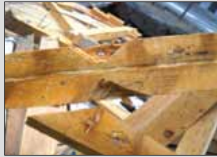
Сл. 7. Груба обработка на дрвото, направени вдлабнатини во носечките елементи и ослабување на напречниот пресек
