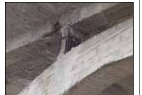
Сл. 3 Алармантни оштетувања на мостовските конструкции на автопатот Скопје – Велес кои пред сè се должат на несоодветното одржување (состојба пред реализација на НАТО-проектот за зајакнување и поправка на мостовите)
