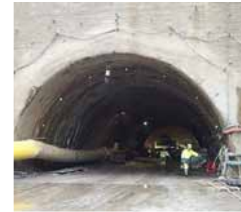
Soumagne Tunnel , Белгија Проект: Bullet train system / Линија: Brussels via Liege and Aachen to Cologne / Monitoring System: 20 различни сензори за мерење на просечни дилатации, multi-point екстензометри, мониторинг на конвергенција, просечна дистрибуција на деформациите во теренот
