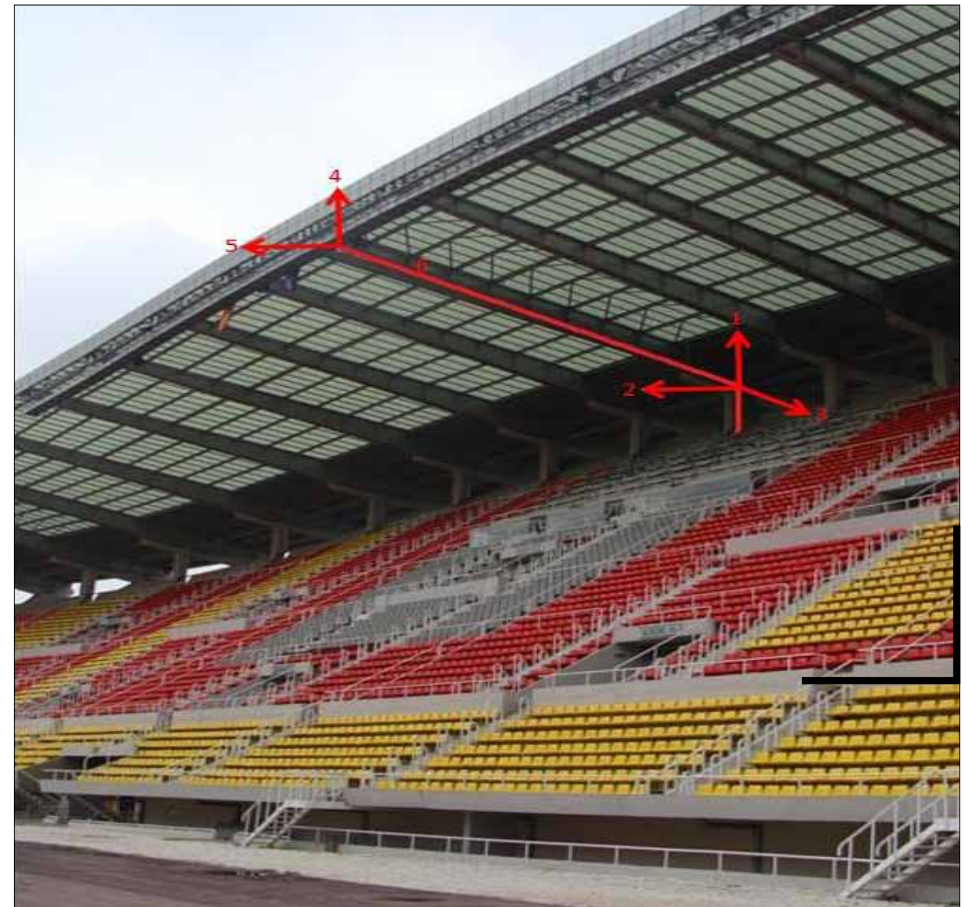
Сл. 7 Експериментален мониторинг на северната трибина на Арена Филип II Македонски – местоположба на сензорите
