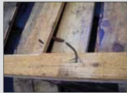
Сл. 13,14. Роговите, подложниците, слемината, столбовите, венчаниците како скоро и сите други елементи се спојувани само со по еден клинец!?, сите подламарински даски се со трулеж и вонкласни
