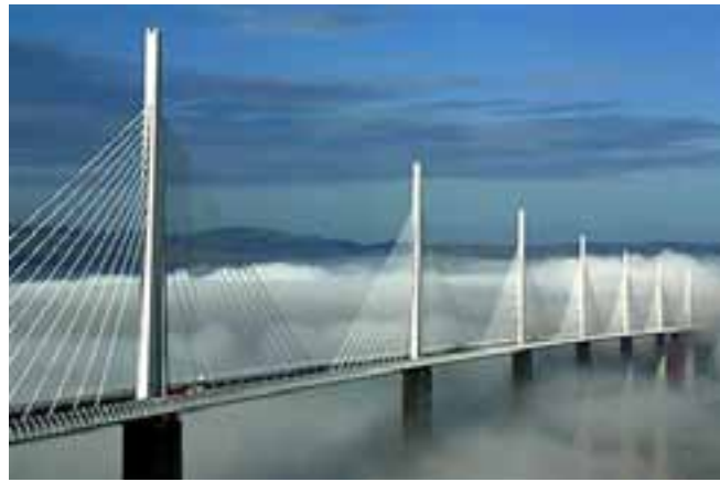
Le Viaduc de Millau , Франција, 400 мил. € Проект: Michel Virlogeux & Norman Foster Max. распон L= 342 m Max. висина H= 343 m Monitoring System: анемометри, акцелерометри, инклинометри, фибер-оптички и електрични екстензометри, пиезо-електрични сензори
