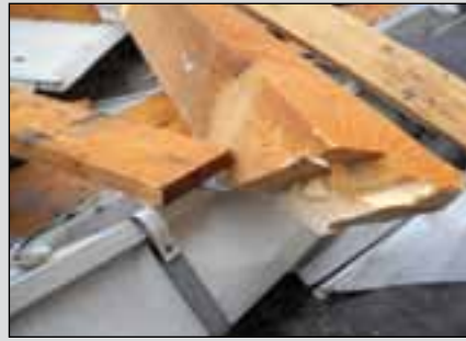
Сл. 8. Изработка на тесарски врски без никаква геометрија и функција
