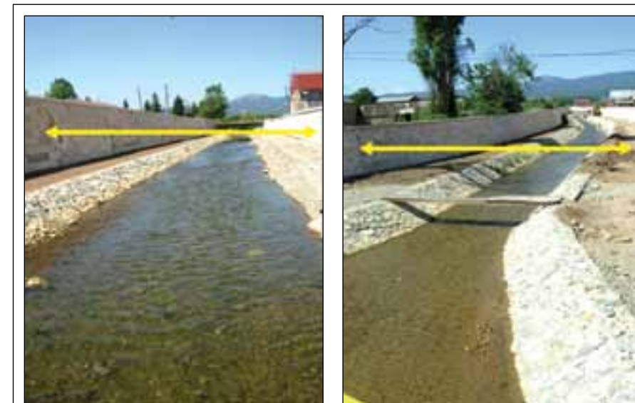
Сл. 3: Канализирано речно корито и стеснет речен коридор на Голема Река во Ресен
