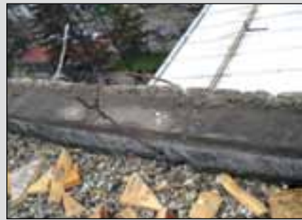
Сл.15. Основата на конструкцијата била прицврстена со вржување со тенка арматура
