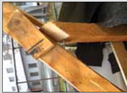
Сл. 13,14. Роговите, подложниците, слемината, столбовите, венчаниците како скоро и сите други елементи се спојувани само со по еден клинец!?, сите подламарински даски се со трулеж и вонкласни
