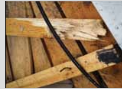
Сл. 11. Како спојно средство користени се едносечни клинци - Тетово, Гостивар, Охрид, но и материјал од претходно опожарениот покрив на Тетовската болница
