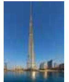
Burj Dubai , Обединети Арапски Емирати, 1,5 мјлд. USD / Проект: Adrian Smith & Bill Baker / Висина: H= 828 (621,3) m / Monitoring System: За прв пат применет Smart Sync-систем за време на градењето. Системот вклучува биаксијални аналогни ацелерометри, биаксијални дигитални акцелерометри, GPS и метеоролошка станица за следење на однесувањето на конструкцијата при дејство на ветер...
