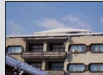
Сл. 2. Сегашен изглед на трето-реконструираниот покрив.
