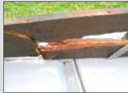
Сл. 16. Употребена е претходно искористена дрвена граѓа и кај истата е завршен процесот на гниење- призматичен трулеж
