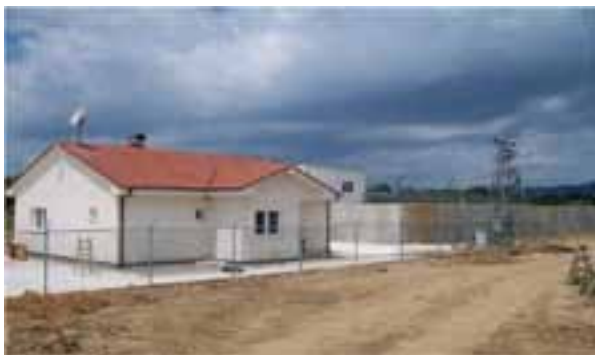
Административната зграда на пречистителната станица во Берово
