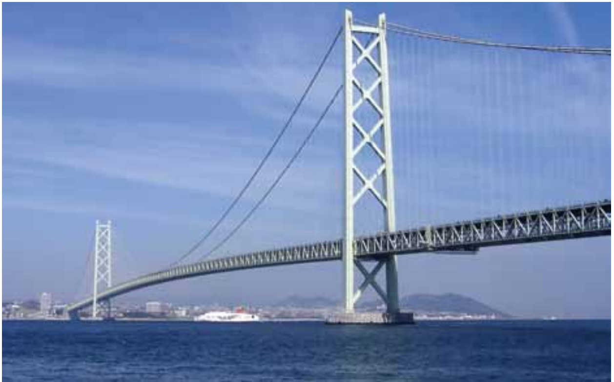
Akashi- Kaikyo Bridge, Јапонија
