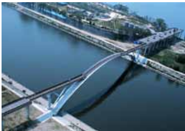
Ултивисокојакосен бетон, Senyo Footbridge, Seoul, Korea
