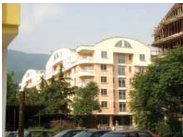
Сл. 6 Изглед на изведениот објект
