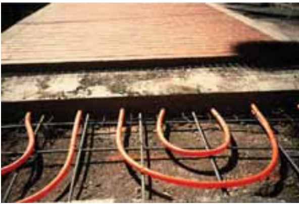
Сл. 2.14. Начин на поставување на пластичните цевки под тротоар -фотографија
