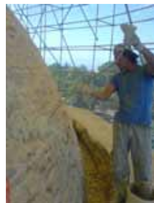
Сл. 13 Инјектирање на сите постојни пукнатини со варов малтер, [7]
