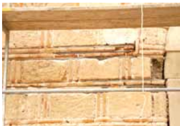
Сл. 11 Чистење на хоризонталните fugи (горе) и поставување на композитни шипки (долу), [7]
