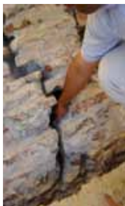
Сл. 13 Инјектирање на сите постојни пукнатини со варов малтер, [7]
