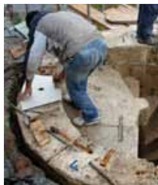
Сл. 13 Инјектирање на сите постојни пукнатини со варов малтер, [7]
