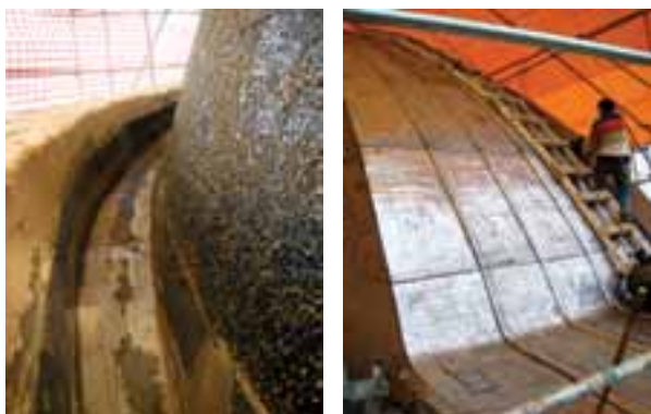
Сл. 10. Обложување на поранешниот АБ-серклаж (лево) и покривање на куполата (десно), [7]
