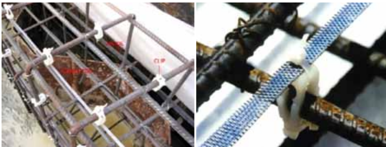
Слика 3. Поставување на анода над челична арматура со пластични држачи
