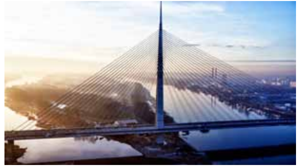
Насловна: Мостот на Сава во Белград Проектант: Виктор Маркељ Фото: Понтинг, Марибор
