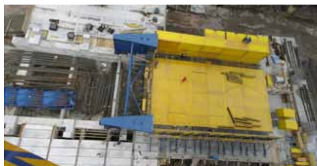
Сл.21. Подготовка на првиот сегмент
