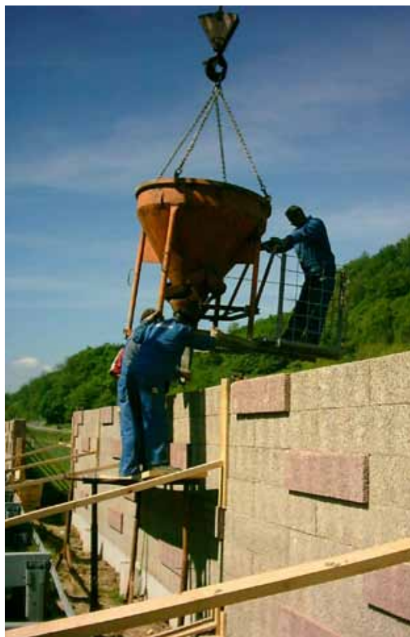
Сл. 5. Изведба на сидови покрај автопат за заштита од бучава
