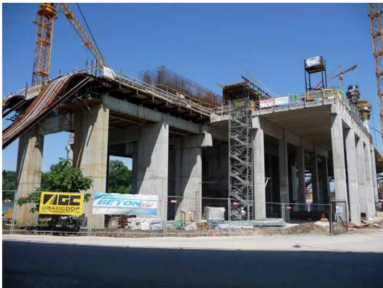
Сл.16. Изведба на лансирната платформа за задниот распон
