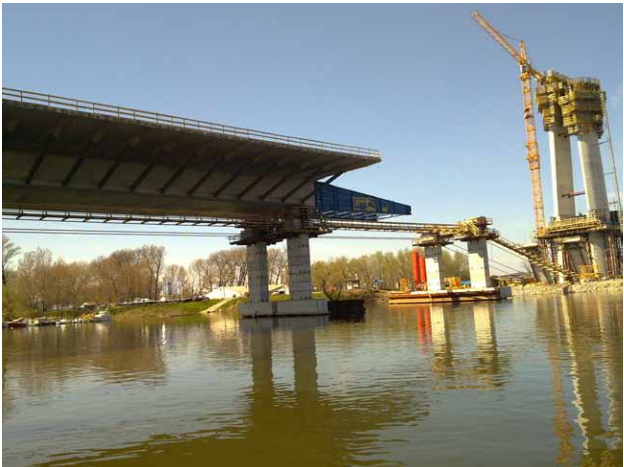
Сл.17. Поставување на задниот распон
