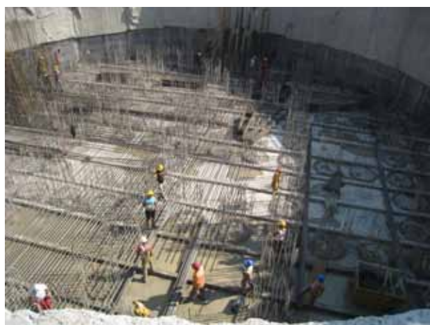
Сл.12. Темелот под пилонот Ø 36m, сид + 131 кол
