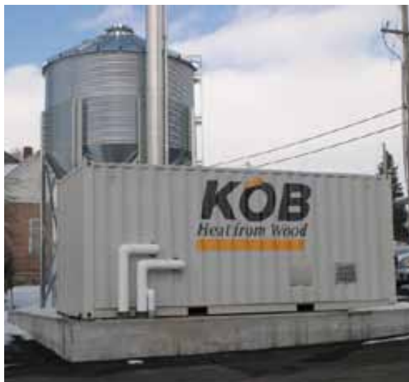
Слика 1. Топлификационен систем со надземен резервоар
