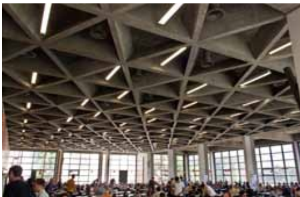
Покривната конструкција на студентската менза во Техничкиот универзитет
