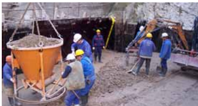
Сл. 4 Детал на бетонирање и вибрирање на бетонот
