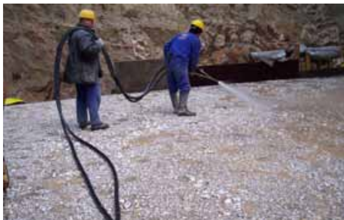
Сл.3 Обработка на контактната површина по завршено бетонирање на една кампада
