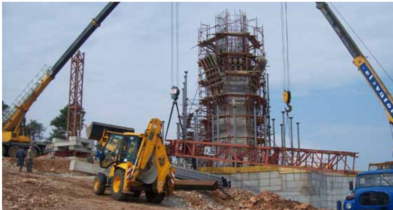
Почеток на одвојување на лачни носачи и дислокација на кран.
