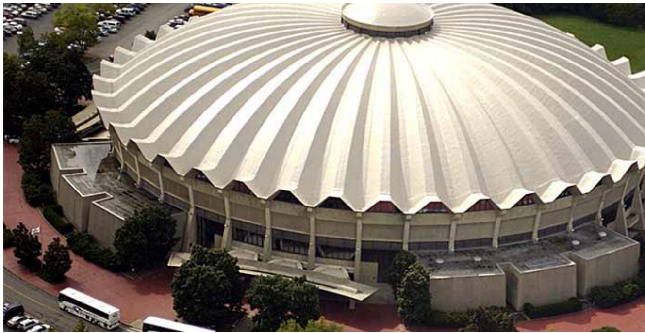
Спортска сала на Универзитетот во Моргентаун, Западна Вирџинија, САД од лесен бетон
