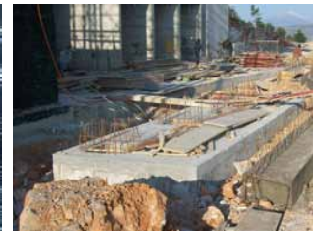
Оформување на партер, конструкција на био јама.
