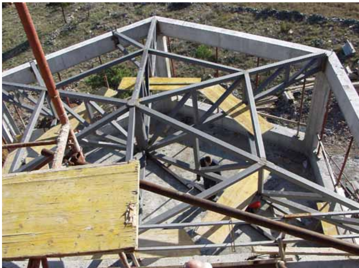
Челична конструкција на кров од една платформа.
