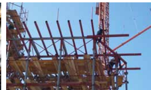
Изработка на платформа за конструкција.
