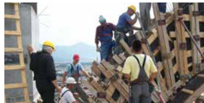
Оплата и бетонирање на лачен носач со следење од надзор, како и за секој елемент.
