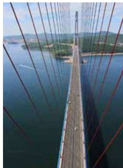
Насловна: мостот Златен Рог, преку заливот на Владивосток и мостот кон Рускиот Остров, што го поврзува рускиот полуостров, со островот Фото: Фресине
