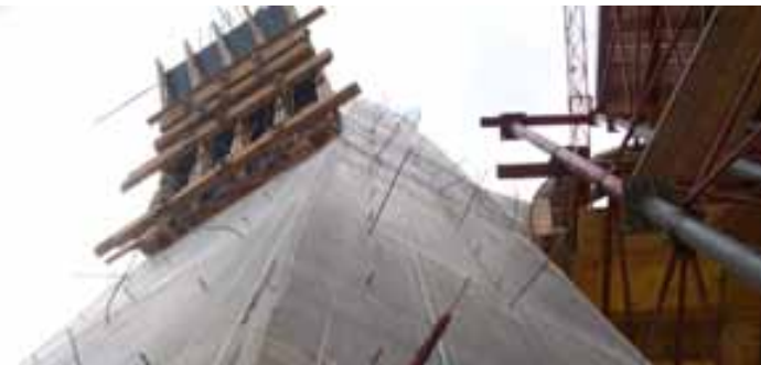
Сидови на торањ со дел од оплата за лачен носач.
