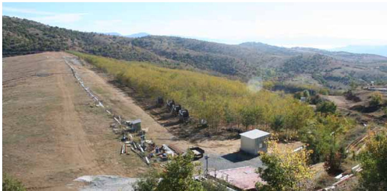
Сл. 1.2. Круна и низводна косина на јаловишна брана Тополница, октомври 2012 година
