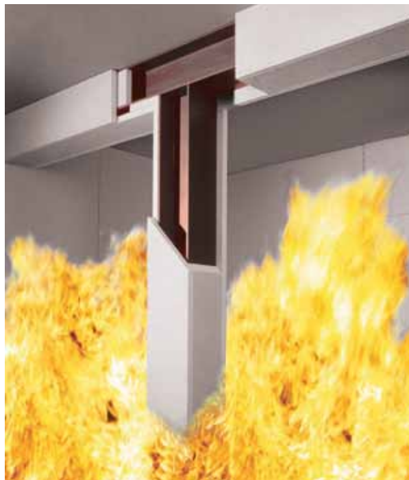
Слика 3. Облога на челичен носач со Fireboard плоча, поврзана со патенти за кламерица
