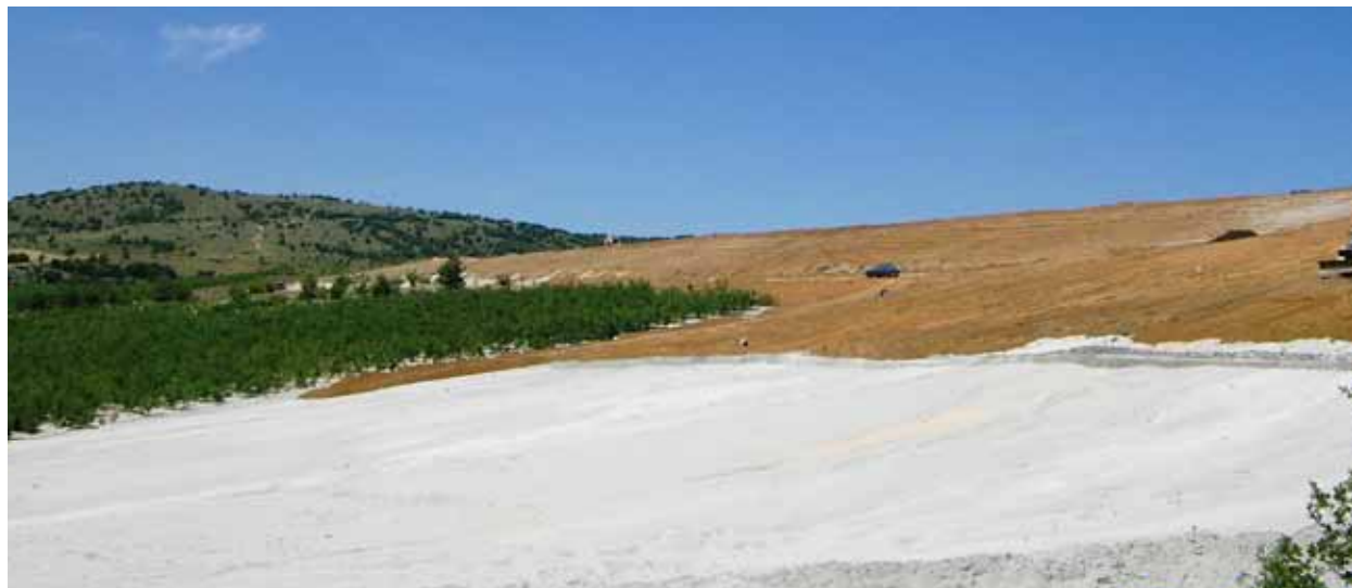
Сл. 1.1. Рекултивација на низводна косина на јаловишна брана Тополница, мај 2010 година
