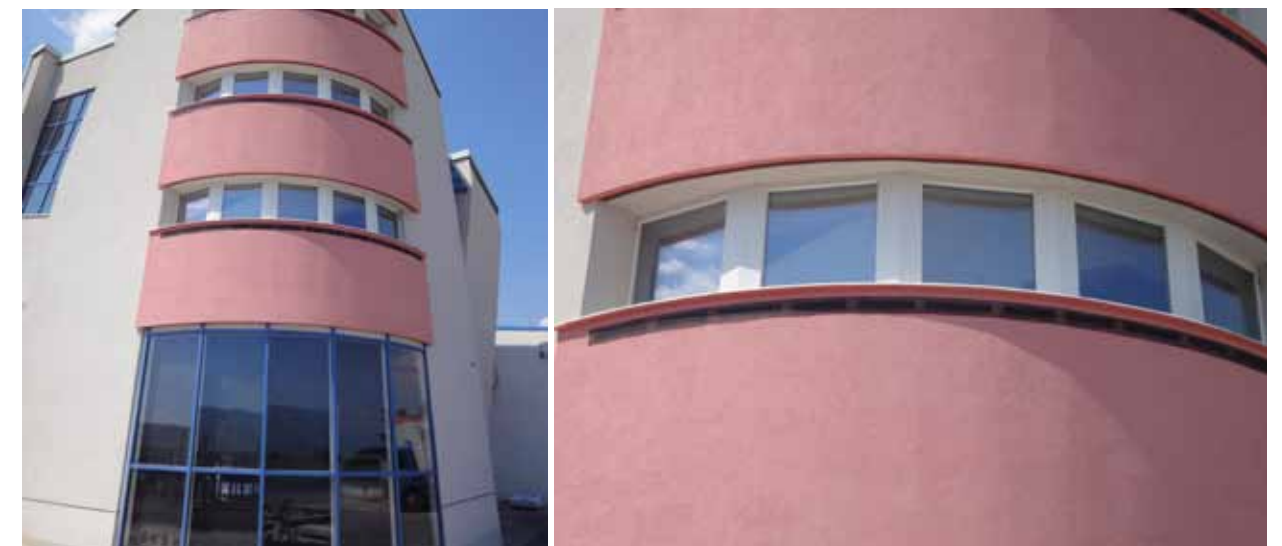
Тромбеов ѕид во објектот на ЕКСПРО Струмица -фасада
