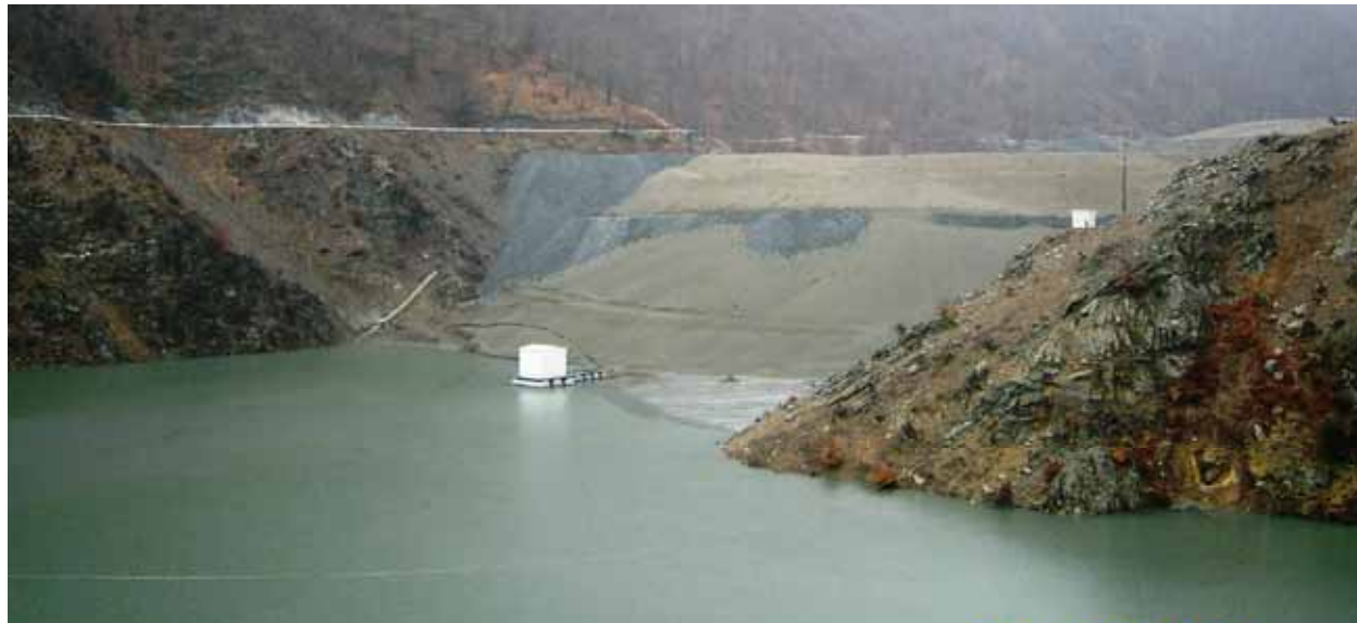
Сл. 3.1. Хидројаловиште Саса, низводна косина на брана бр. 3-1 и таложно езеро на јаловиште бр. 3-2, март 2011
