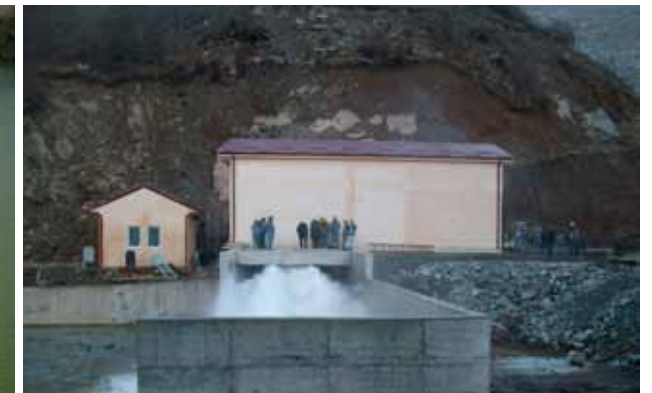
Пробна работа на темелниот испуст
