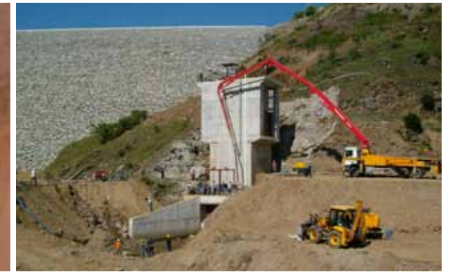
Зачепување на опточниот тунел
