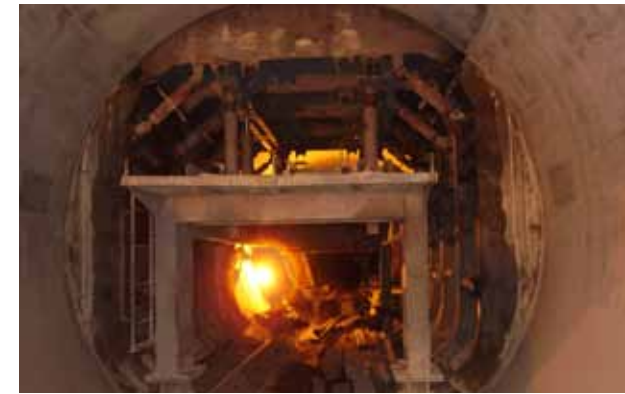
Изградба на тунелот
