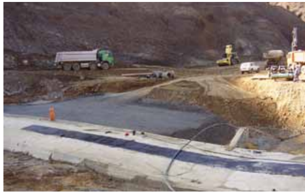
Фундирање на асфалтното јадро
