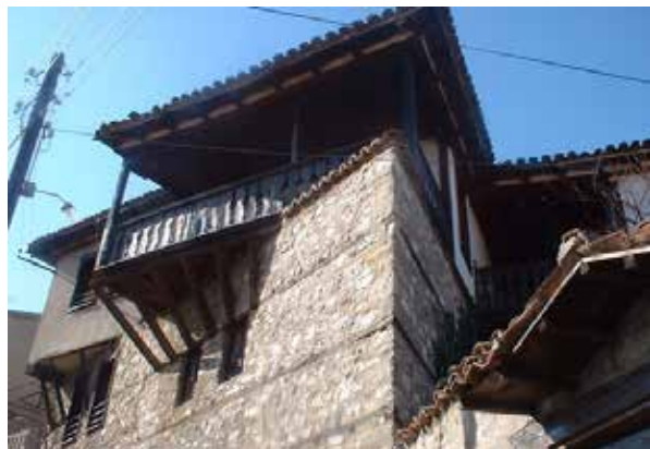
Слика 12. Куќа во Велес, 19 век Неправилната форма на основата на приземје е диктирана од урбанистичките и теренските услови. На катот е исправена со помош на исфрлување на триаголни еркери за да се формираат прави одаи и чардак
