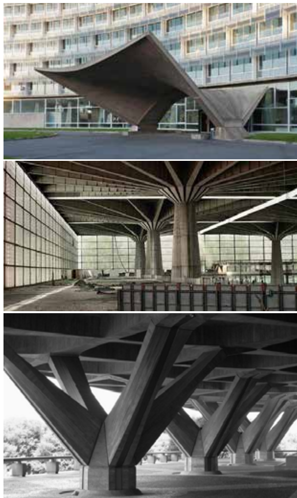
П.Л. Нерви, УНЕСКО-центар во Париз, 1957 г На фотографиите се дадени сите важни конструктивни детали: посебно профилирани столбови, брановидни меѓукатни конструкции и армирано-бетонска лушпеста конструкција на влезот. Тој совршено владее со слободна и лесна игра на сили, правејќи го исто така и успешен конструктор. Познат е и како архитект-конструктор на неколку спортски хали
