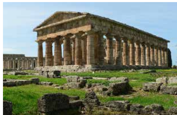
Херинов храм во Пестум, 5 век Употребен е природен камен кој не дозволува поголеми распони и отсликува строгост, масивност, монументалност и вечност
