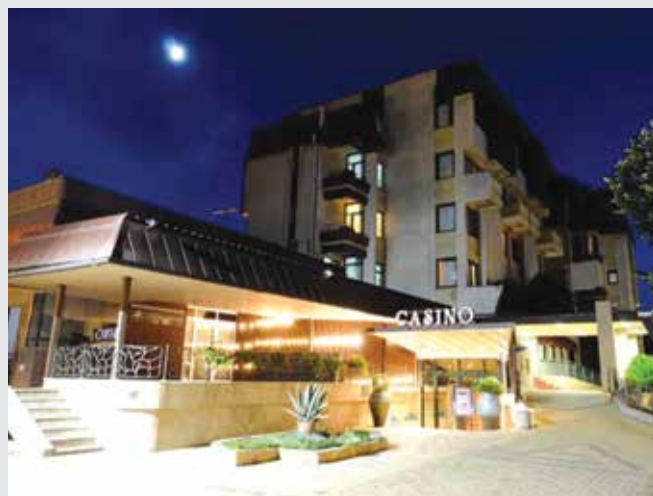
Хотел Југо (Аполонија), Гевгелија Има приземје и 4 ката. Проектиран е во 1978-1979 година. Откако беше реновиран го носи името Аполонија и функционира пред сè како казино.
