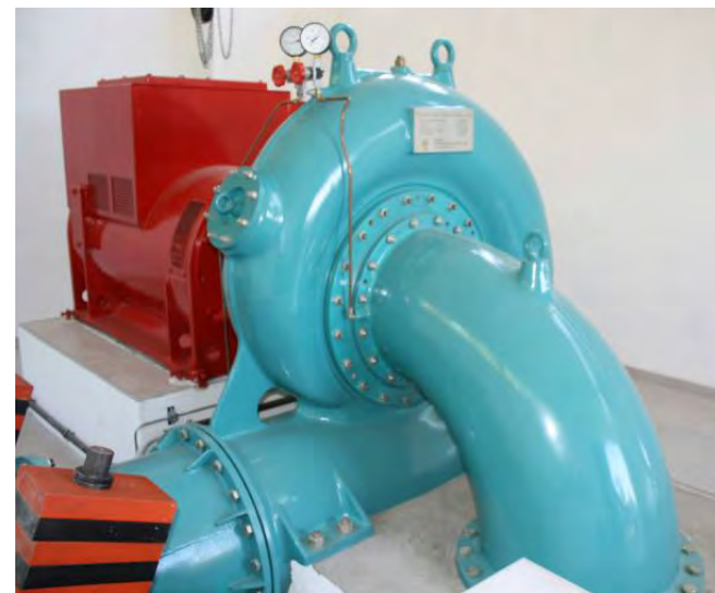
Слика 1. Вградена Францис турбина во МХЕ
