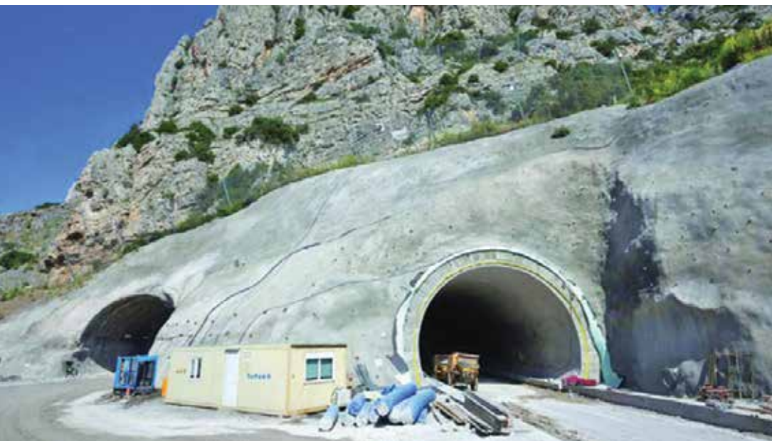
Слика 1. Влез на тунел на автопатот Е-75, делница Д. Капија-Смоквице
