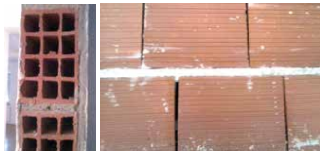
Слика 2. Грешки при изведба
