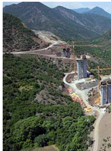
Слика 2. Изградба на мост на автопатот
