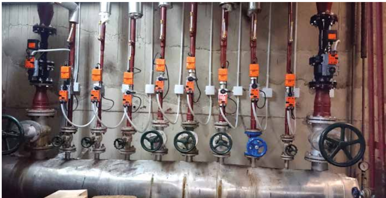
Слика 4. Инсталација на електронски, притисно независни регулациони контролни вентили во машинска сала во објект НУ МОБ
