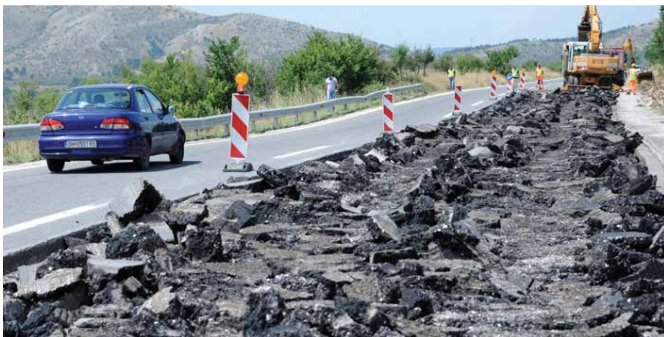
Слика 5. Санација на коловозот на автопатот Е-75, делница Велес-Катланово
