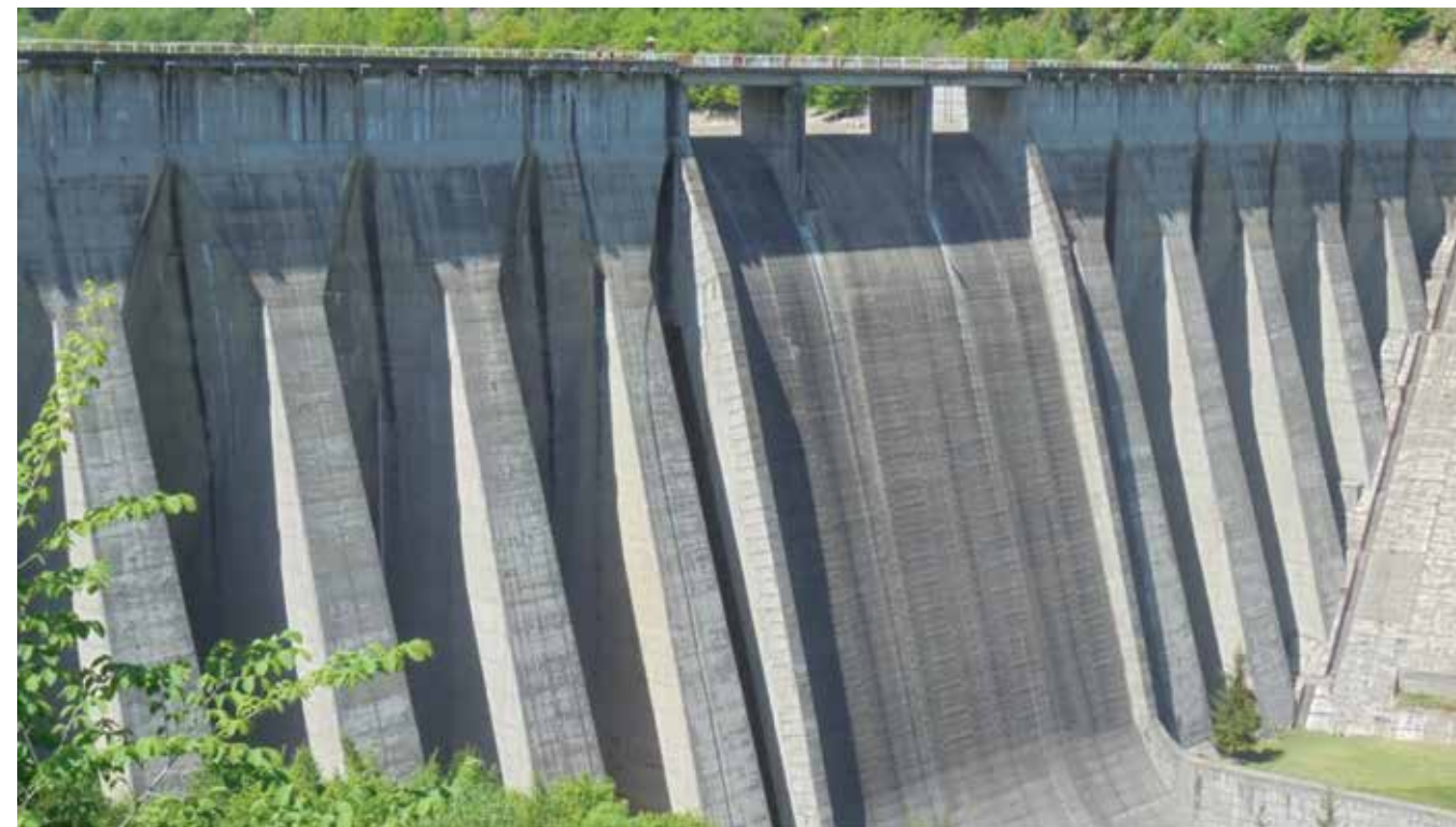
Gura Rauliului, низводна страна на контрафорна брана со челен преливник во тело на браната, составена од 22 блокови со широчина од 15 м и дебелина на контрафори од 4,5 до 8 м
