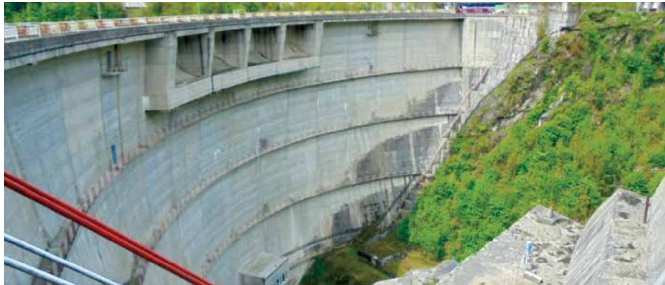
Tau, лачна брана со двојна закривеност и челен преливник
