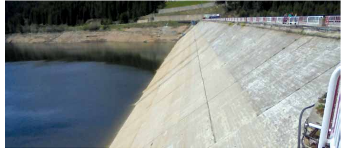
Oasa, каменоносипна брана со армиранобетонски екран
