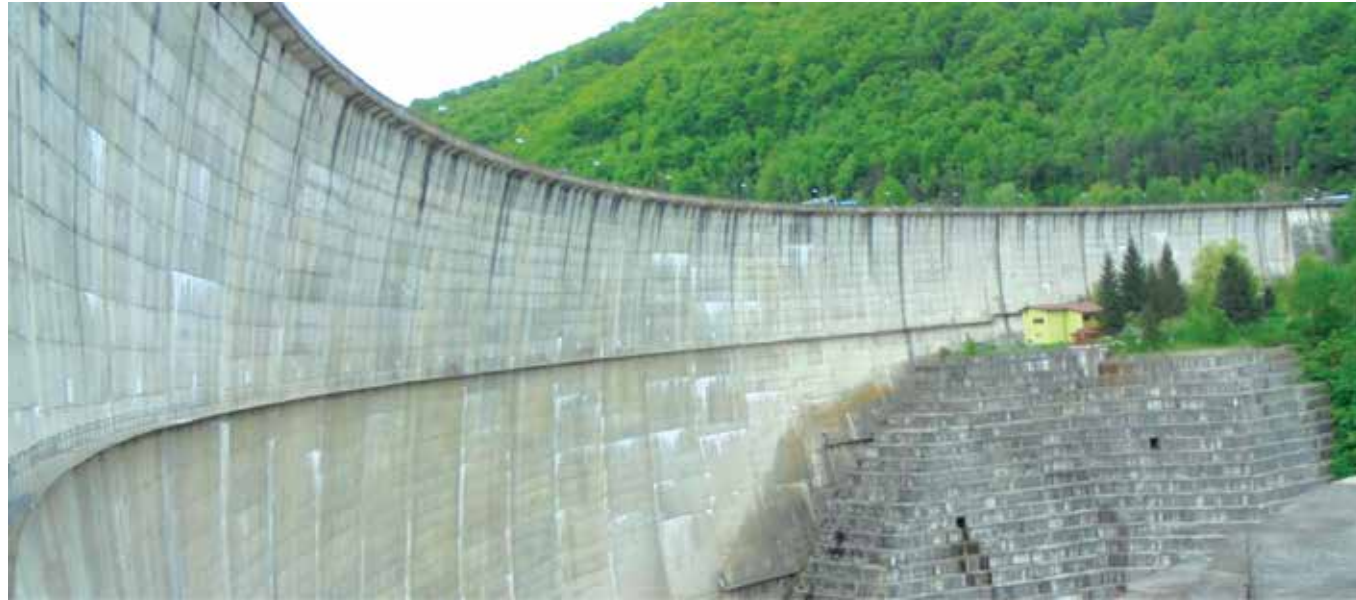
Paltinu, централна лачна брана до двојна закривеност, со параболично крило во левиот бок на долината поради топографска несиметричност и гравитациони блокови за зголемување на носивоста на карпестиот масив на низводната страна
