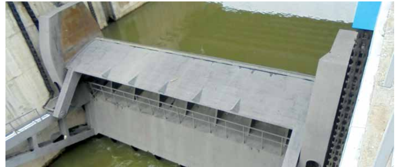
Racovita, речна хидроцентрала, сегментен затворач на преливен орган - основен
