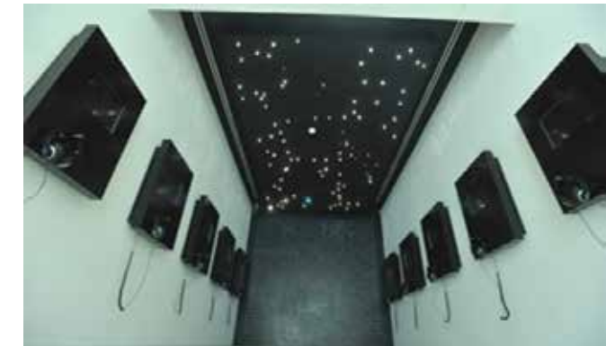
Светилки со халоген извор на светлина, пренос на светлина преку оптички влакна (просторија за слушање музика, 75W моќност)
