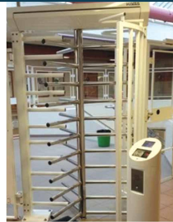
Овој систем на движечка вртлива врата, кој се користи заедно со читачи на картички, може сигурно да го контролира пристапот без да има потреба од набљудување од страна на човечки фактор
