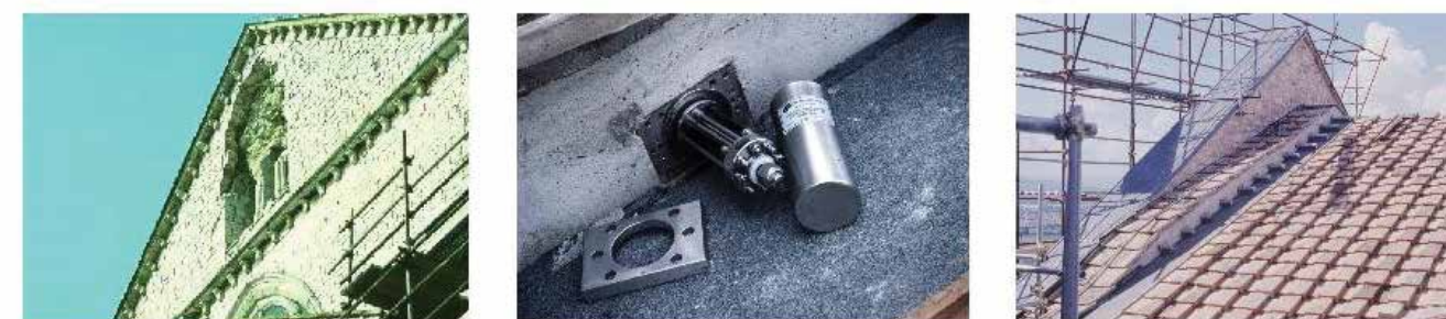
Слика 7. Изолатор со контролирана врска на тимпанот со покривот на базиликата St. Francis во Assisi, Италија
