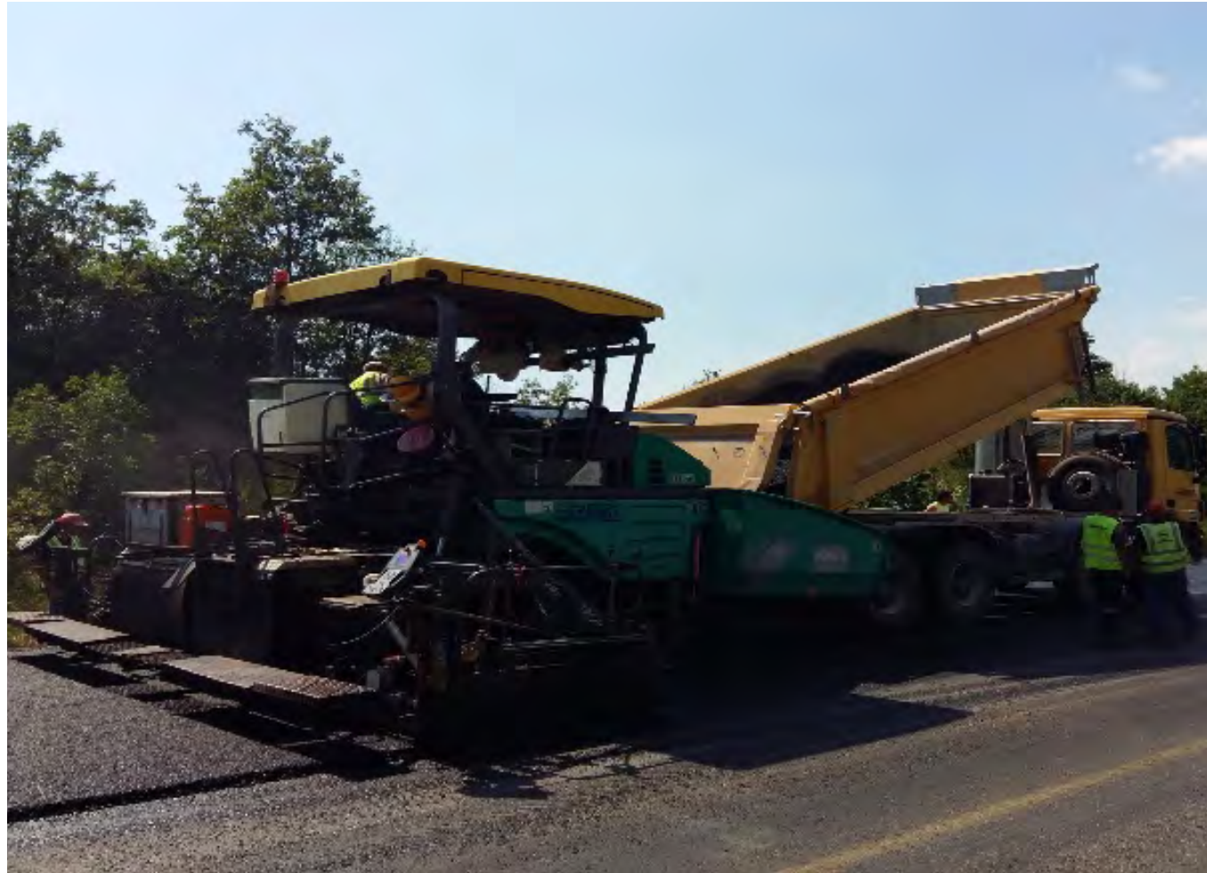
Поставување нов асфалт бетонски слој
