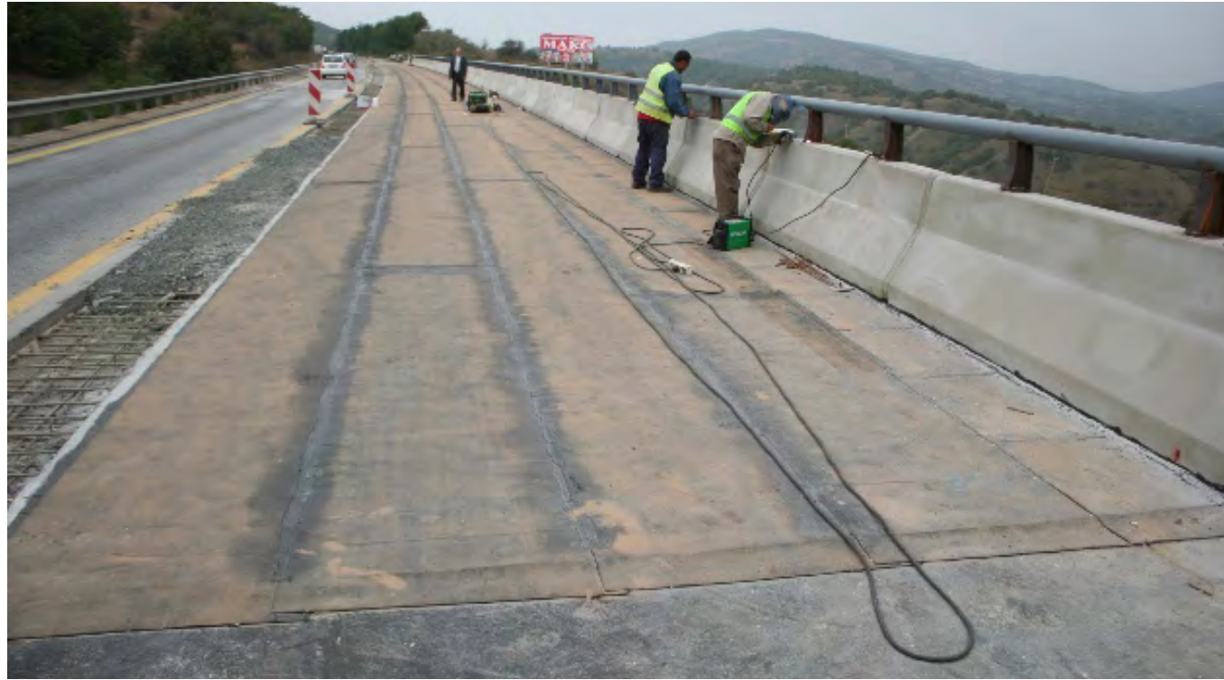
Поставување хидроизолација на мост и одбојна ограда
