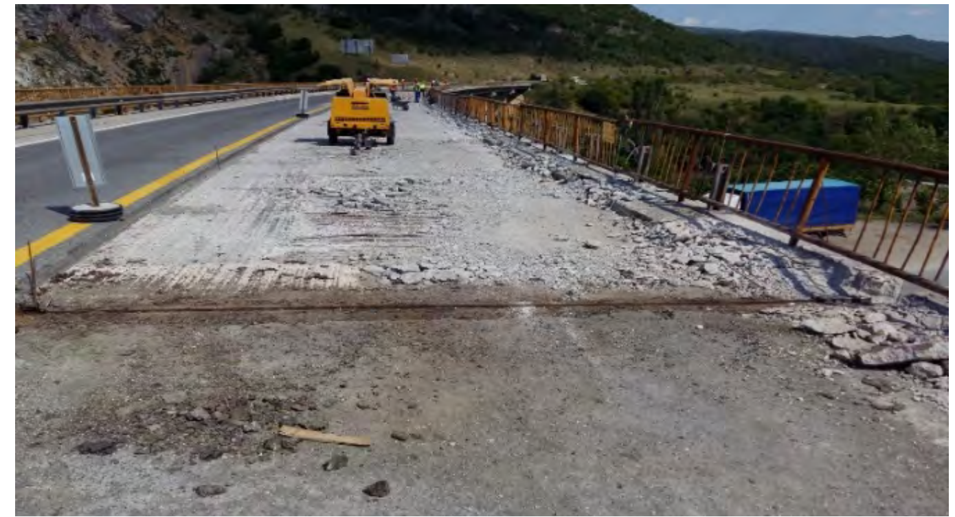
Расчистување на оштетена коловозна конструкција на мост
