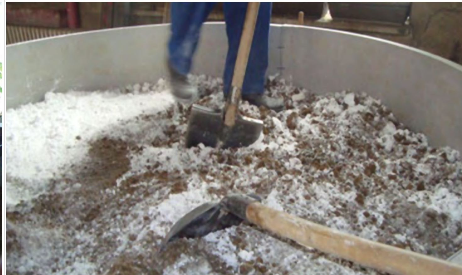
Слика 10. Подготовка на темелна подлога и пробно товарење на плиток темел
