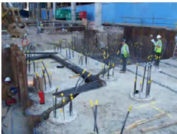
Слика 2. Инсталација на цевки во геотермален кол
