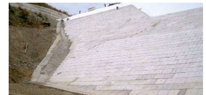
Сл. 11. Брана Лошана, каменонасипна со геосинтетички екран, изградена во 2006, H_s = 45 m
