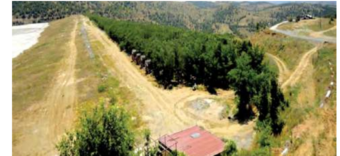
Сл. 15.1. Јаловишна брана Тополница, на рудникот Бучим, со рекултивирани низводна косин, завршена во 2015 година
