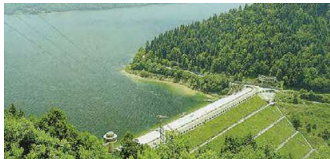
Сл. 5. Брана Маврово, изградена во 1957 година, прва насипна брана во Р Македонија
