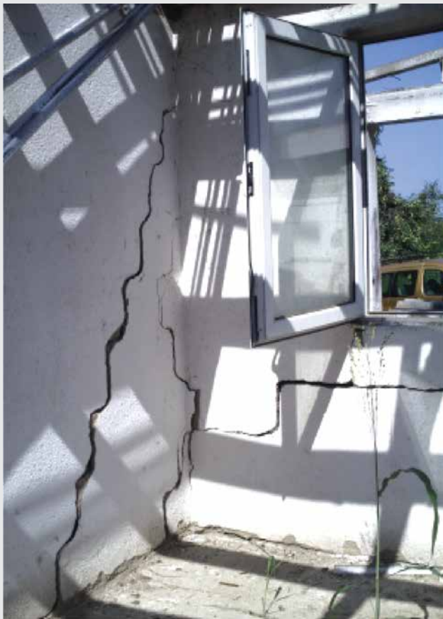
Слика 2. Свлечиште на патот Кратово – Пробиштип и оштетување на објект од свлекувањето
