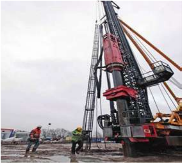
Слика 2. а) Инсталирање на арматурен кош б) Бетонирање
