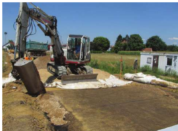
Слика 7. Преднапрегнување на геомрежа со помош на странични ровови
