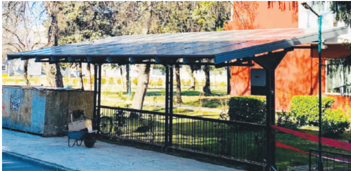
Слика 1 а. Инсталиран паметен фотоволтаичен модул во дворот на ФЕИТ
