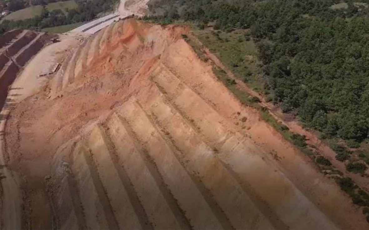
Слика 1. Големо свлекување каде што се зафатени повеќе берми, усек на стац. км 3 + 400, секција Кичево – Подвис
