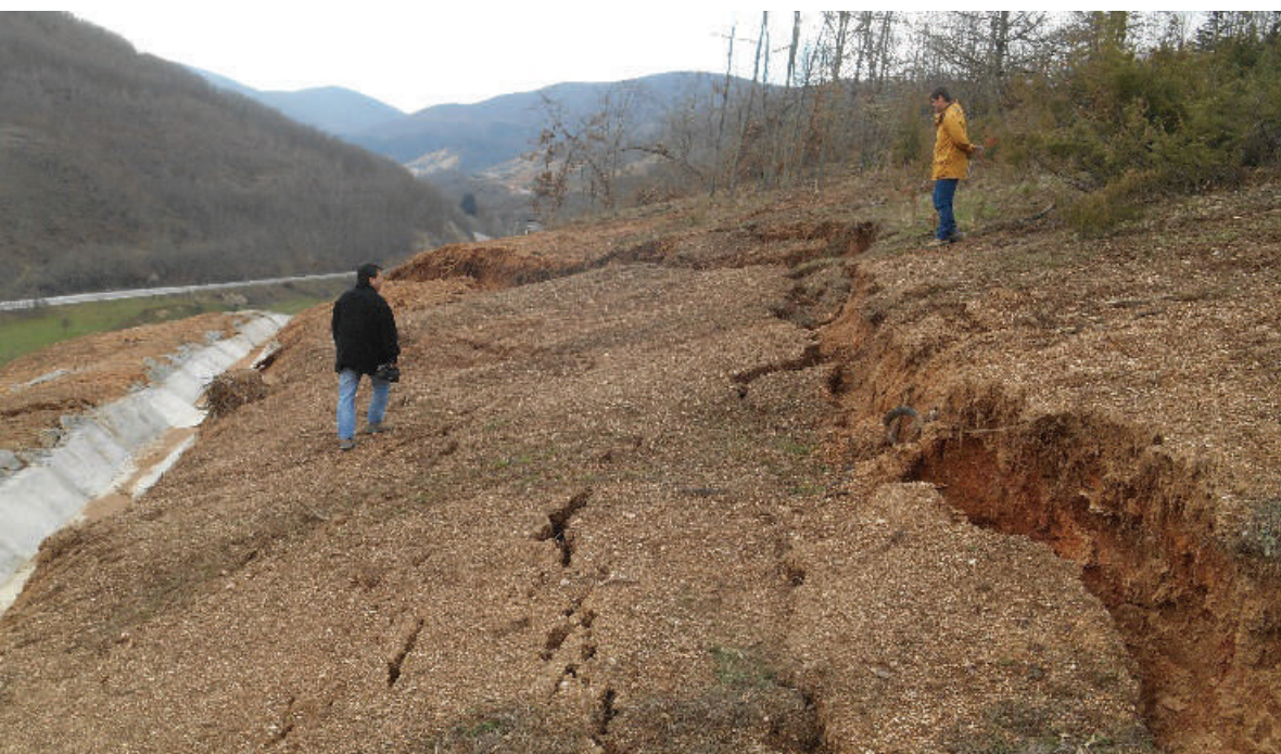
Слика 2. Чело на свлечиште, настанато во фаза на изведба на косините на усек на стац. км 15 + 200, секција Подвис – Пресека
