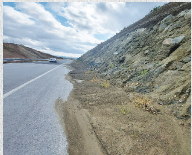
Слика 1. Косина со изразена ерозија на материјалот (автопат Миладиновци – Штип)
