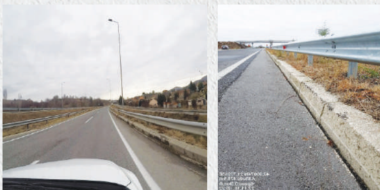
Слика 6. Високи рабници А1 (Е75), км 26 + 400 и км 3 + 400
