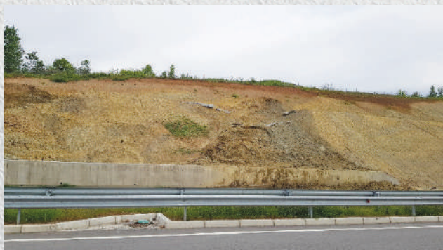
Слика 2. Локално (плитко) свлекување на косини од автопатот Миладиновци – Штип
