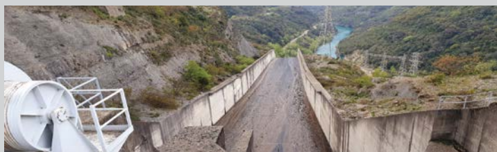
Брана Кремаста, челен преливник со сегментен затворач и брзотек со ски скок, 25.4.2023
