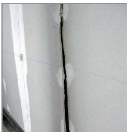
Различни нивоа на оштетувања на Кнауф системи при хоризонтално или вертикално поместување до 27 mm
