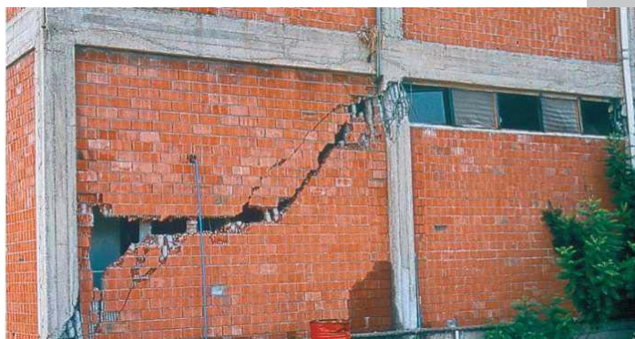
Оштетувања на ѕидарија и конструктивни елементи поради крута изведба, Адана, Чејхан, Турција, 1998
