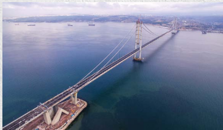
Слика 11: Osman Gazi Bridge, Турција, завршен во 2016. Главен распон 1550 m Фото: COWI
