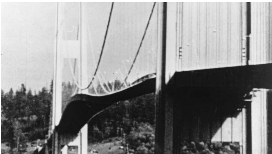
Слика 2: Уривањето на First Tacoma Narrows Bridge во 1940 година. Главен распон од 853 метри
