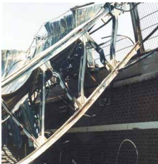
Слика 1: а) Колапс на опожарена АБ плоча б) Колапс на опожарен АБ столб в) Колапс на опожарена челична решетка
